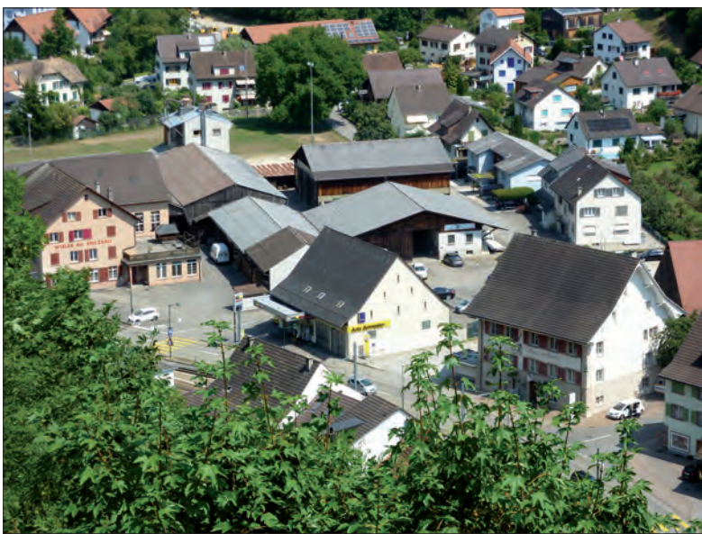
Die Firmenareale der Wisler AG und der Schneider AG sind mehr als doppelt so gross wie das Gemeindeland Husmatt (im Hintergrund).
