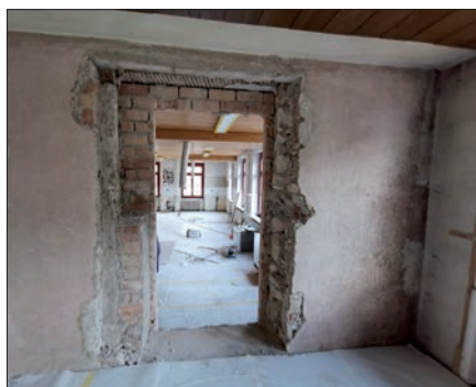
Umbau im Schulhaus Holde.
