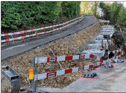
Im August begonnene Bauarbeiten am Stutzweg.
