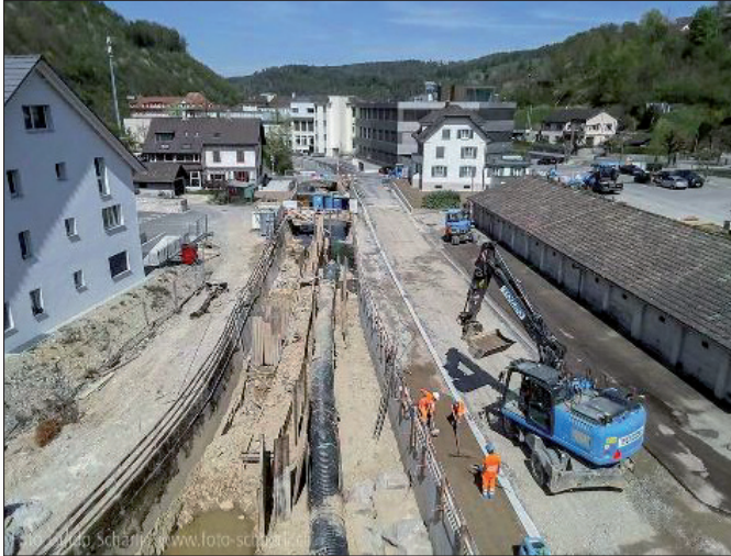
Die Grossbaustelle Ribigasse während den letzten zwei Jahren.
