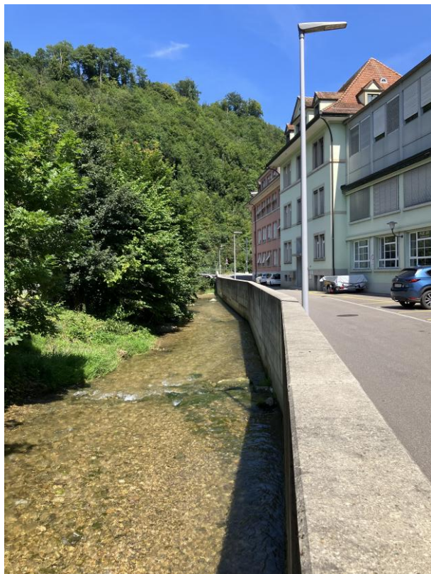
Abb. 22: Vordere Frenke, Abschnitt 3, Hochwasserschutzmassnahme entlang der Ribigasse
