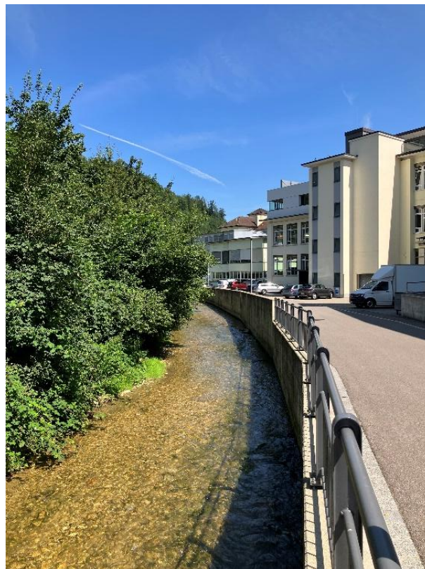
Abb. 23: Vordere Frenke, Abschnitt 3, Blick Richtung Norden
